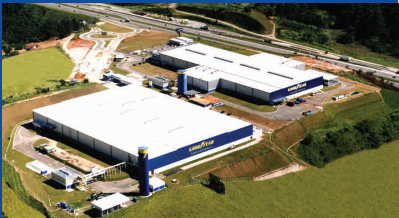
Nova fábrica de Correias Automotivas na Rodovia Castello Branco - Santana de Parnaíba - SP
